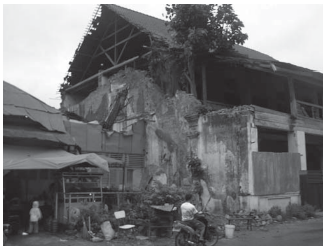
被災した町並みの歴史的建造物
