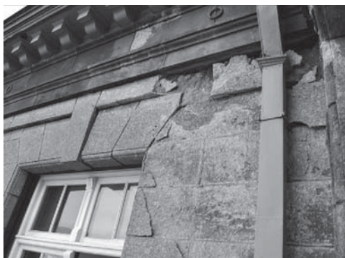
壁石の劣化状況（旧日本郵船小樽支店）
