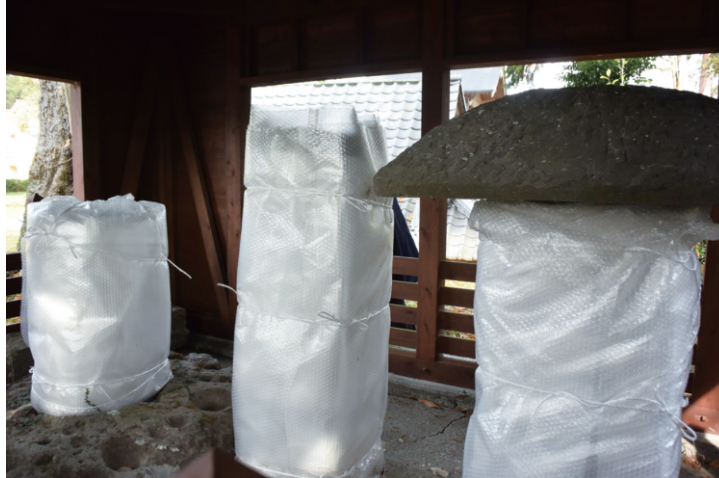
図1 浄水寺碑（被災後応急処置状況）
