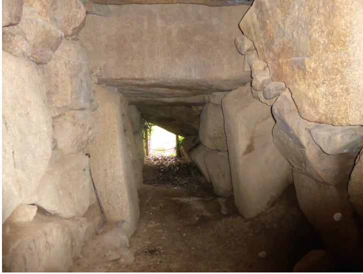
図1 横穴式石室天井石が傾斜した状態の古墳 羨道側壁（写真右側）が倒壊し、天井石が大きく傾いている（写真奥）。
