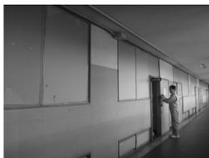
図2 窓側の遮光（左，発泡スチロール），廊下側の遮光（右，段ボール）の様子
