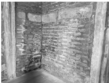
図24 アヤ・イリニ聖堂 アトリウム回廊部の壁面
