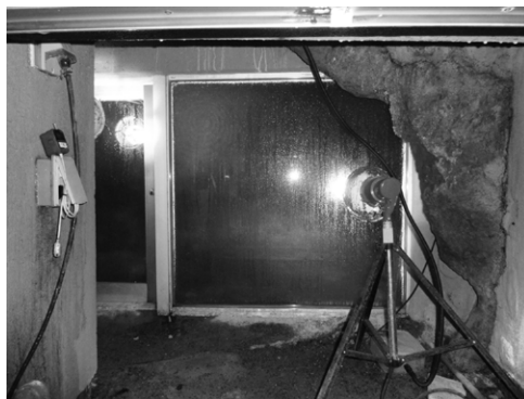
図6. 清戸迫横穴のガラス密閉式保存施設
