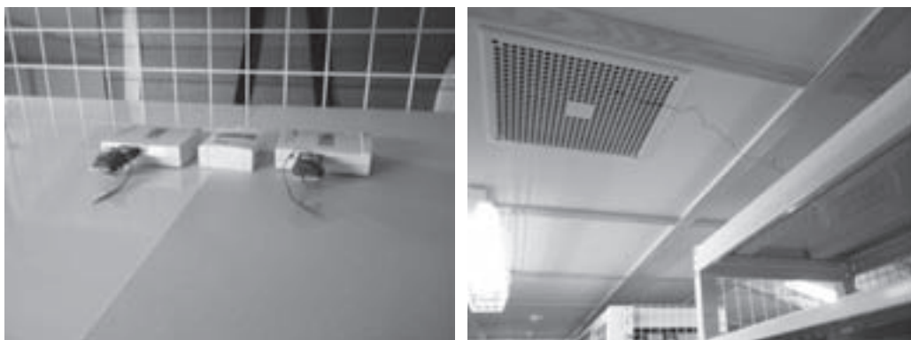
図3 測定に用いたデータロガーの設置状況
