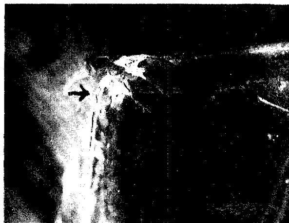
25 蓋裏にみる下地（白い部分）
