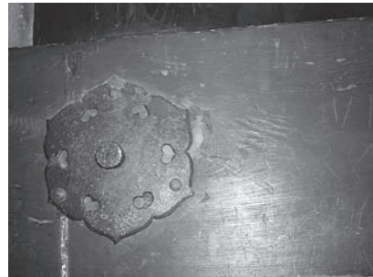
写真 4-2 天正期修理の釘隠し金具下にみられる試料 No. 3 の塗装痕跡と横の大正15年の落書き
