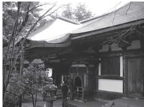
写真3 石山寺本堂の現況
