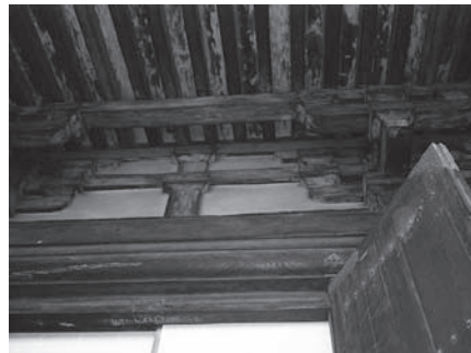
写真2 建造物外観塗装における赤色顔料の残存状態
