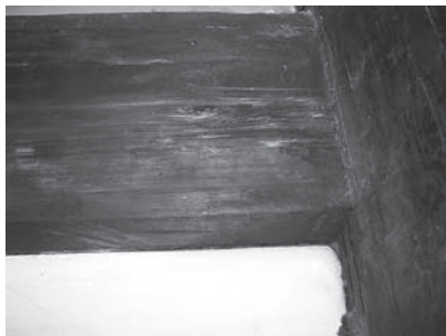
写真 4-3 試料 No. 4 の塗装痕跡
