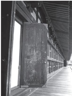
写真 4-1 試料 No. 1 の塗装痕跡
