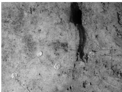
写真1 天井の漆喰表面に発生したカビの例 (2007年7月24日)
