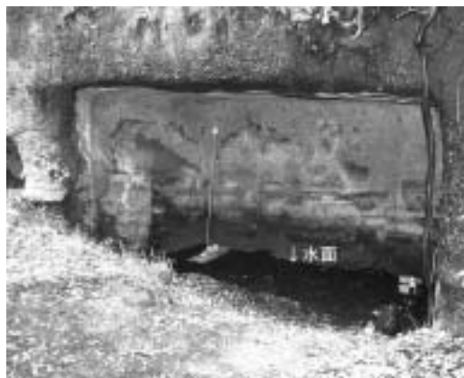
図6 大五輪やぐら内部にできた水面 (2003年4月9日撮影) 入り口天井からは雨だれが認められ、やぐら内には深さ30cm程で水面が形成されている。
