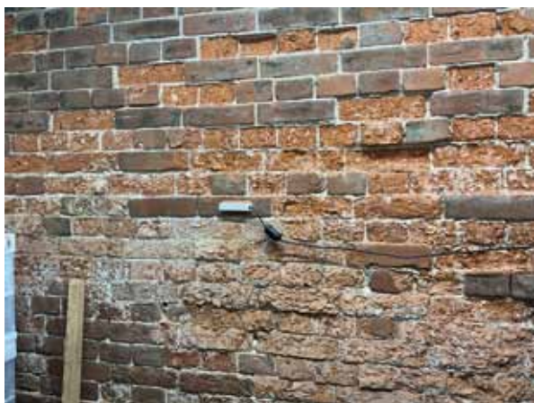
図 煉瓦倉庫におけるモニタリングの様子
