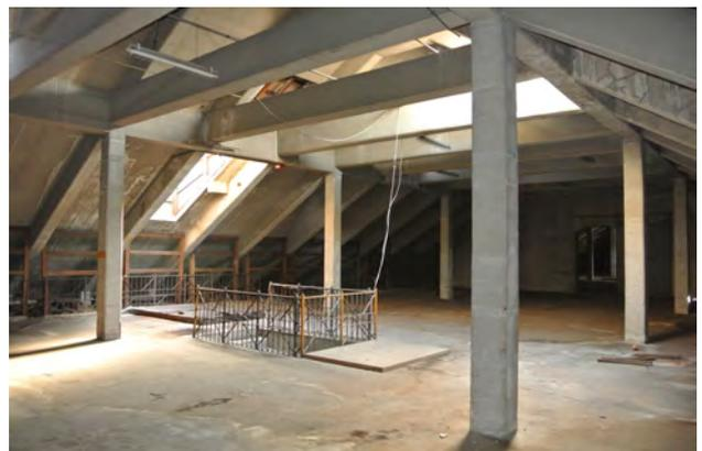
旧広島陸軍被服支廠 1913年建築の鉄筋コンクリート構造(木骨煉瓦造の木部を鉄筋コンクリートに置き換えて不燃化を図ったとみられる)
