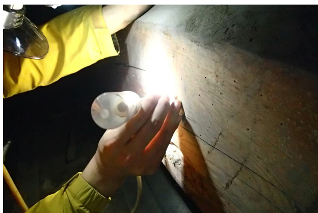
木造文化財建造物から虫糞を採集する様子
