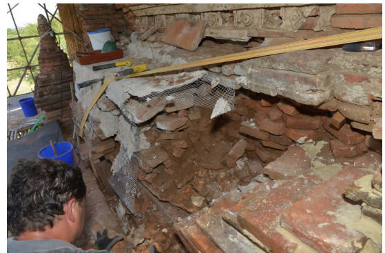
震災による被災箇所処置風景
