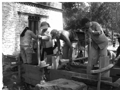
版築ブロックの施工実験
