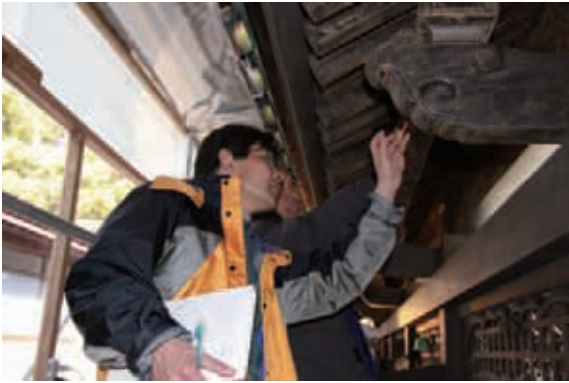
建造物漆塗装に関する調査（日光二社一寺）
