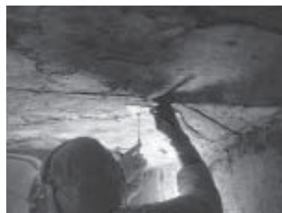
天井の星宿図の取り外しの様子
