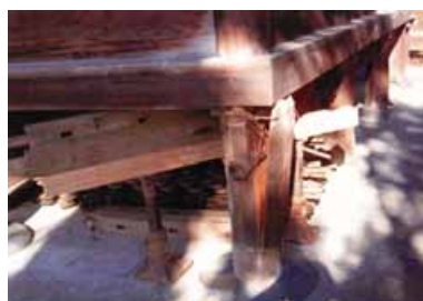
魚沼神社阿弥陀堂 東南隅柱の応急補強
