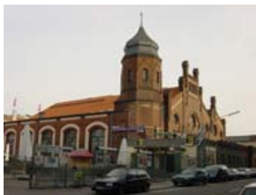
19世紀末の発電所を利用したイベントホール
