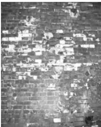
図1. 凍結したレンガ (碓氷第6トンネル側壁)
