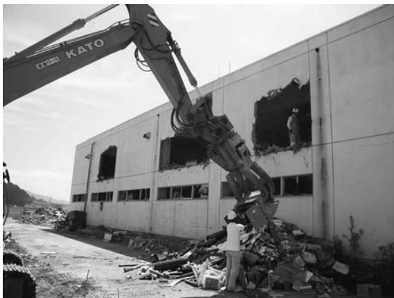
被災した文書庫からの搬出作業（平成 24 年 7 月）
