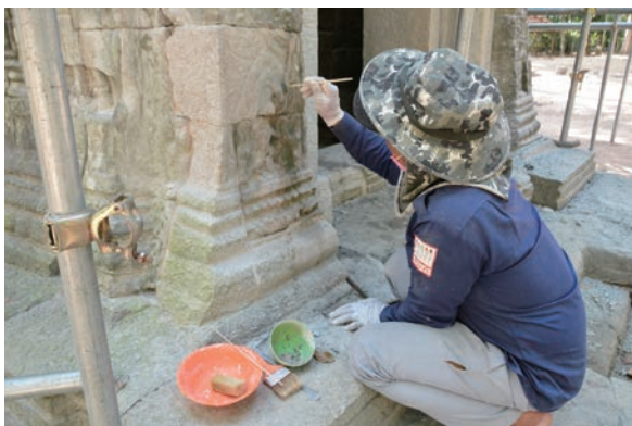
東門再構築後の補修作業
