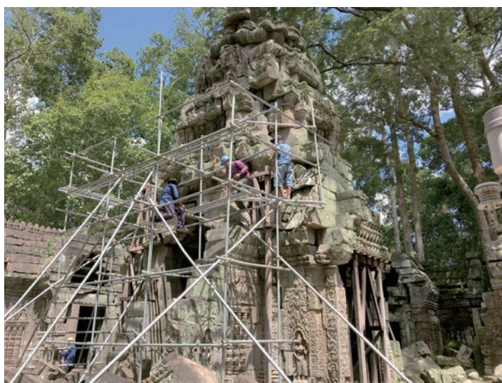
中心伽藍東塔の危険箇所 応急補強置き替え
