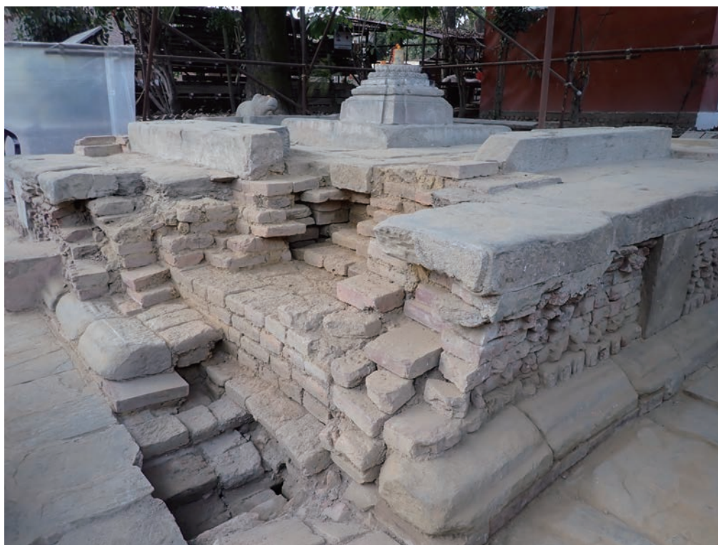
解体調査によって露出した基壇内部の当初と思われる構造
