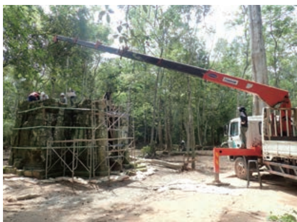
クレーントラックによる解体作業 Dismantling work with a crane truck
