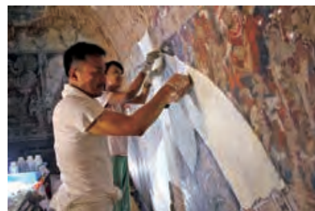
水酸化バリウムを用いた壁画補強技術に関する研修(マンマーバガン) Training on a consolidation technique for mural paintings using barium hydroxide treatment (Bagan, Myanmar)
