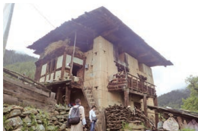
伝統民家の保存・改修方法に関するフィールドワーク(ブータン) Field study on the appropriate conservation / renovation of traditional farmhouses (Bhutan)
