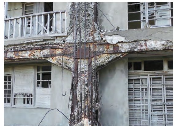
端島(軍艦島)の劣化した鉄筋コンクリート造集合住宅。鉄材の錆によりコンクリート壁が劣化剥離している。 Reinforced concrete apartment house on Hashima Island (Battleship Island, Nagasaki City, Nagasaki Prefecture) The concrete wall was deteriorating due to the rusting of the steel structure.
