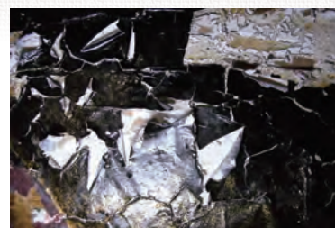
過去に使用された修復材料の劣化により生じた損傷 Damage due to the degradation of materials used in previous restorations
