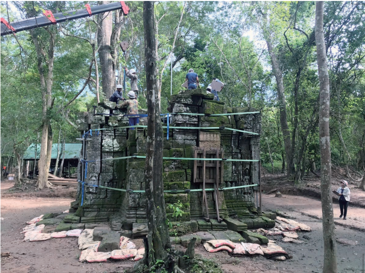
上： 屋根の解体作業 中左：壁の解体作業 中右：基礎構造の発掘調査と地盤強度試験 下： ボールカメラを用いた写真測量
