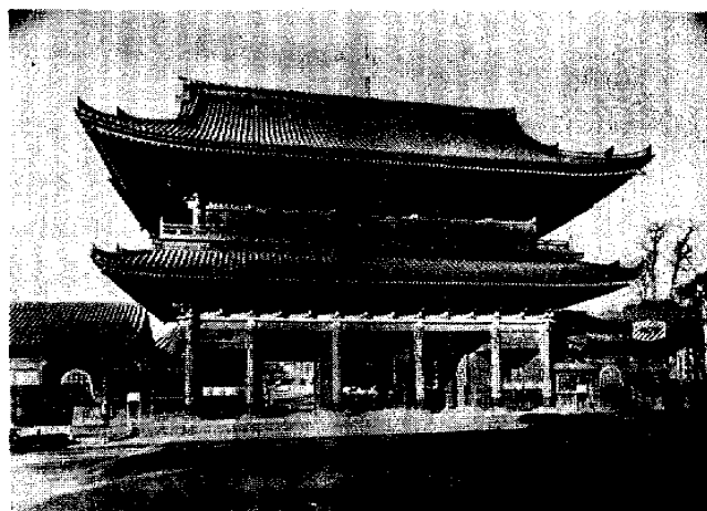
図-1 解体前の重要文化財増上寺三解脱門
