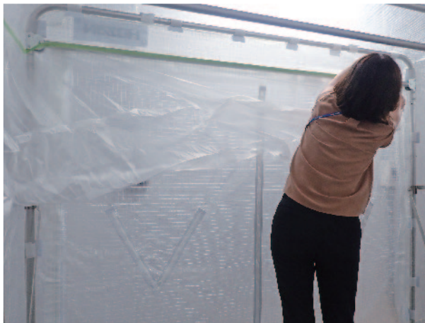
図3 陰圧ブース内部の壁面にマスクを貼る様子
