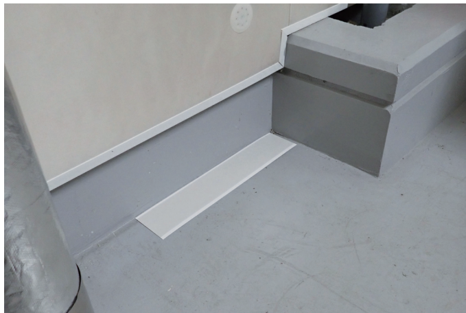
図2 機械室の壁際に設置した粘着トラップ
