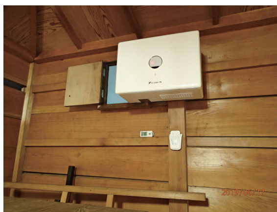
図5 除湿機設置の様子
