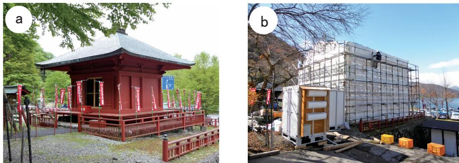
図4 湿度制御した温風処理が行われた中禅寺愛染堂(a)と処理時の様子(b)
