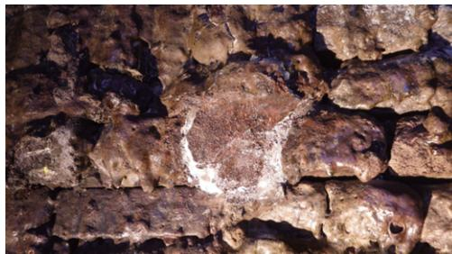
図4 窯内部北東隅の樹脂膜内から析出した塩類
