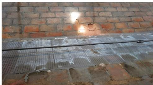
図10 窯の屋根南面 塩類析出箇所
