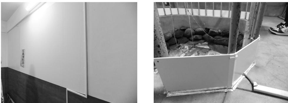
図3 結露対策として窓を塞いだプラスチック製のパネル（左）と鉄柵下部に取り付けた板（右）
