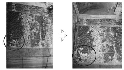
図3 ギャラリー階北西壁面における塩の析出状況(左:2006年11月,右:2010年9月)
