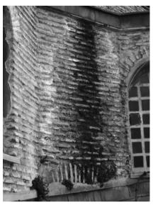
図8 西外壁の植被と雨水の浸入痕
