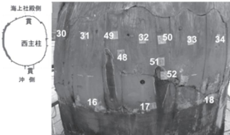
図6 西主柱根継ぎ部付近の外観と測定位置- 4
