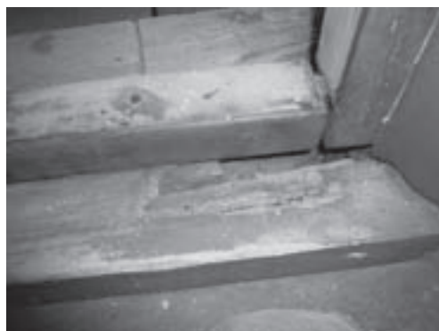
図5 中禅寺鐘楼においてオオナガシバンムシの被害によく似た被害箇所
