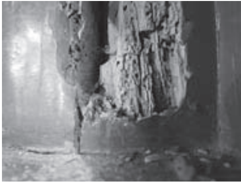
図1 中禅寺立木観音堂の柱の被害写真
