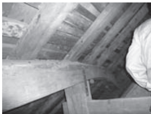
図10 虫孔が非常に小さく、チビキノコシバンムシの食害と考えられる被害箇所
