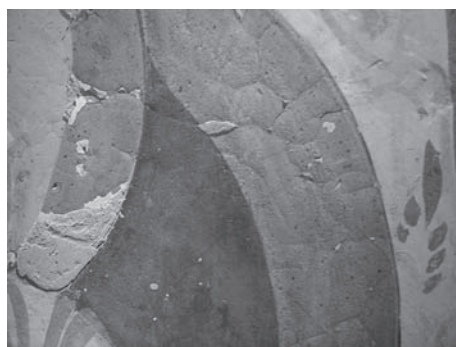
写真5 彩色層の亀裂(北壁中段、千仏の光背)
