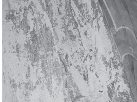
写真7 彩色層の剥落（西壁）
