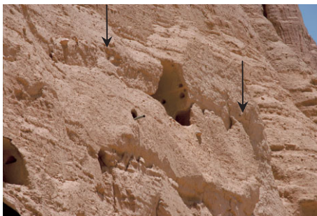
写真5 I窟坐仏龕前面の大規模な亀裂
