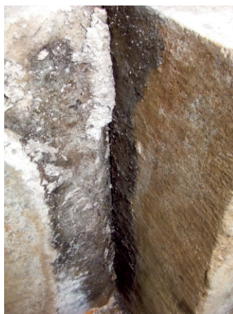
写真6 南壁と東1石の接合部の漆喰を外した後（2007年6月11日）
