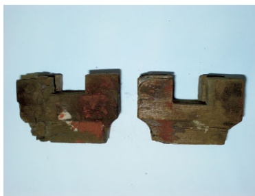
写真6 試料No.19, 20の奈良時代当初材 である大斗の外観塗装の状態
