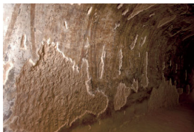
写真 2 I窟右繞道 エッジング処置後
