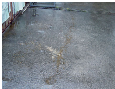
写真9 DDACによるコンクリートの着色
