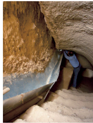
写真6 トンネル内に設けられた排水溝
