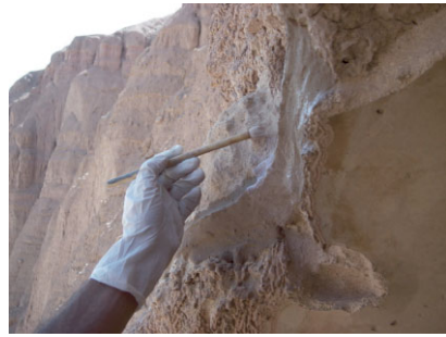
写真4 モルタル製の庇
