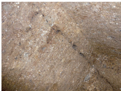
写真10 地震痕跡の亀裂の例（2007年8月20日）
