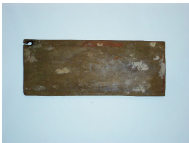
写真7 試料No.21の奈良時代当初材で ある壁板材の外観塗装の状態
