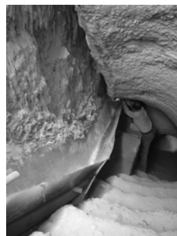
写真6 トンネル内に設けられた排水溝
