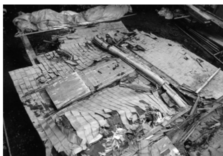
写真3 倒壊した八窓庵
