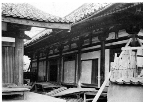
写真2 昭和解体修理前の本堂北背面と禅室
