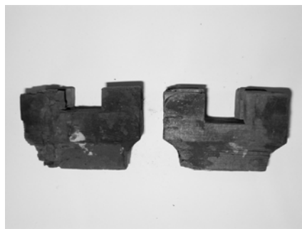
写真6 試料No.19, 20の奈良時代当初材である大斗の外観塗装の状態
