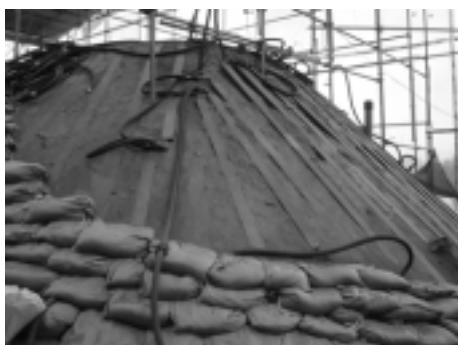
写真2. 墳丘部表層部に設置した冷却管
