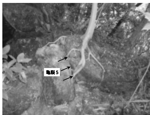
写真4 木の根が入り込んでいる亀裂5
