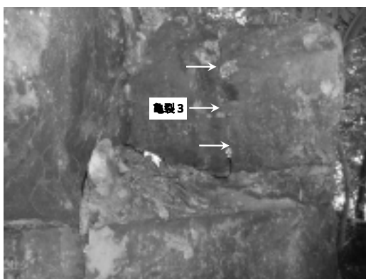
写真3 右壁面にある亀裂3
