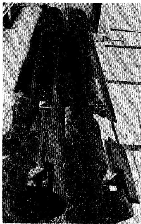
付図-29 新巻柱 素地固め
