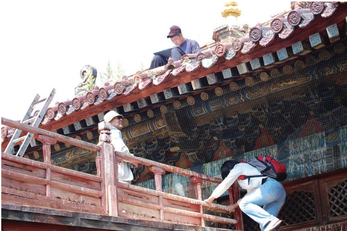
建造物保存修復調査風景
