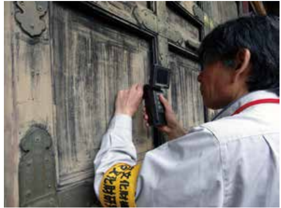
文化財建造物における漆塗装の劣化状態調査 (日光東照宮本殿)
