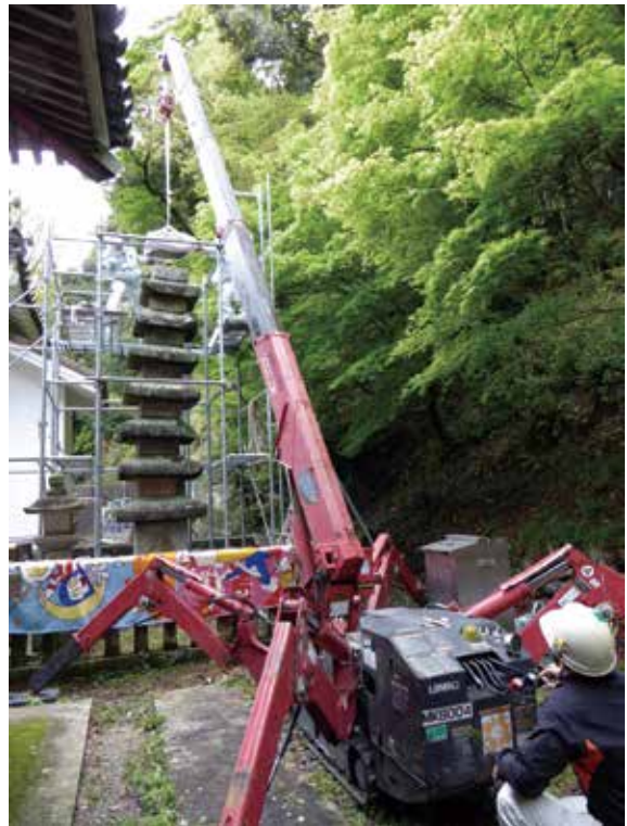
宝積寺九重石塔の解体作業(京都府大山崎町)
